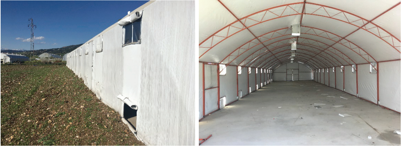
Şekil 28. Çadır tipi kümeslerde aydınlatma penceresi, tavuk giriş çıkış yeri ve iç kısımdan görünüş
