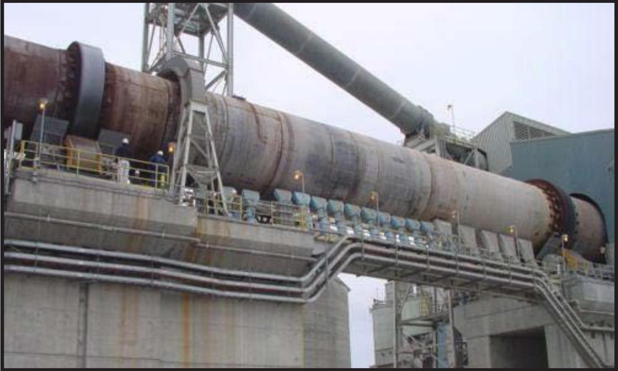
Şekil 1. Çimento üretim fabrikası döner fırın
